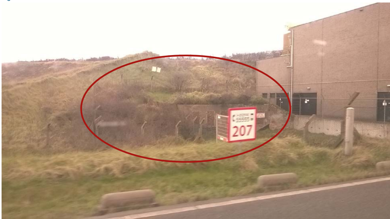
Figuur 4: Situatie TNT bunker
